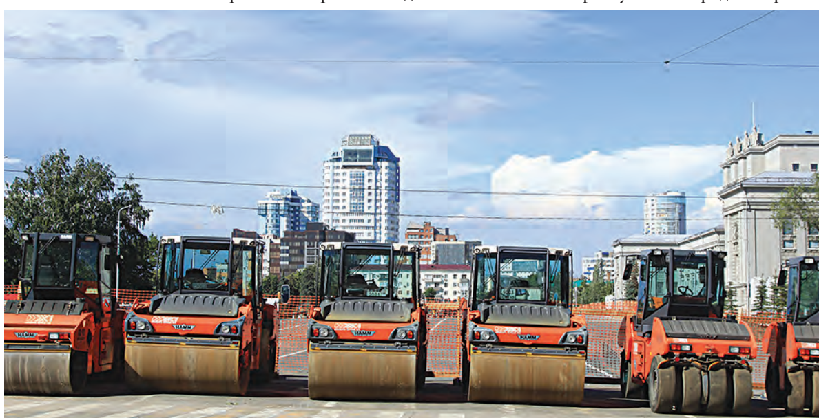
Главная городская площадь - имени Куйбышева - сейчас закрыта на капитальный ремонт.
