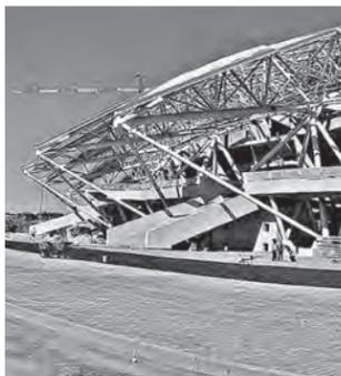
Об этом сообщает компания-застройщик ПСО «Казань». Также сейчас на «лепестки» купола монтируют профнастил - подоснову будущего комбинированного кровельного покрытия из ПВХ-мембраны и поликарбоната. Уже готово девять лепестков из 32. А на третью декаду сентября намечено отсоединение временных поддерживающих опор от металлоконструкций купола.
