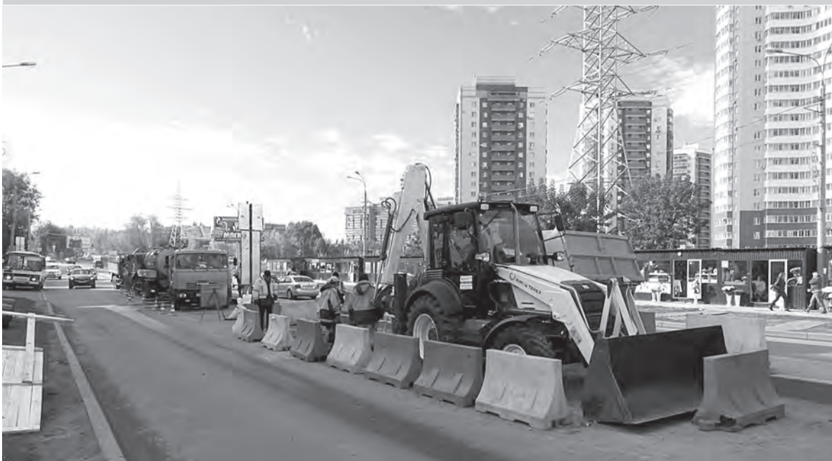
Ремонт коллектора дождевой канализации на ул. Солнечной
