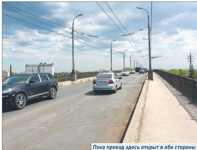
Пока проезд здесь открыт в обе стороны
