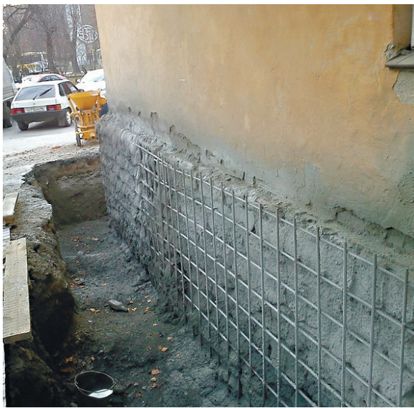
ремонт цоколей (42 дома);
