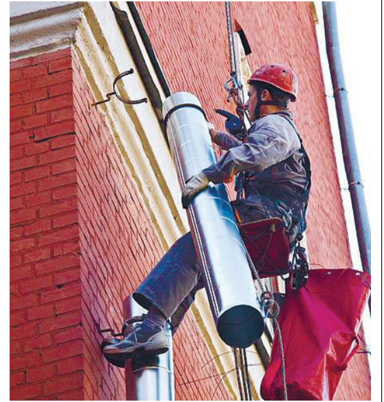
ремонт водосточных труб (301 дом);
