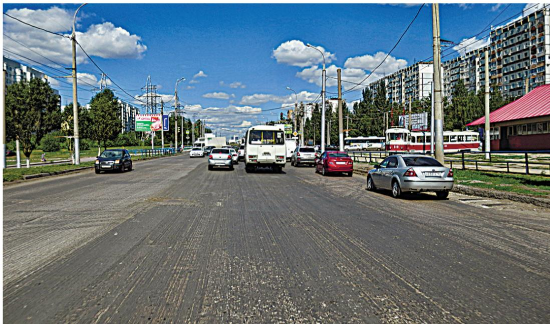
Сейчас подрядная организация НПФ «XXI век» проводит укладку нижнего, так называемого выравнивающего слоя на проезжей части. Затем будет положен верхний слой с применением щебеночно-мастичного асфальтобетона с полимерно-битумным вяжущим. Специалисты утверждают, что такая технология позволяет увеличить срок жизни дороги. Особо прочные материалы выбраны еще и потому, что по улице Земеца постоянно движутся тяжелые машины.
