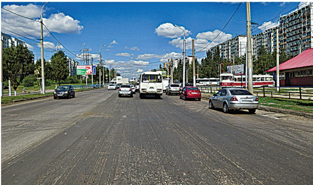
Сейчас подрядная организация НПФ «XXI век» проводит укладку нижнего, так называемого выравнивающего слоя на проезжей части. Затем будет положен верхний слой с применением щебеночно-мастичного асфальтобетона с полимерно-битумным вяжущим. Специалисты утверждают, что такая технология позволяет увеличить срок жизни дороги. Особо прочные материалы выбраны еще и потому, что по улице Земеца постоянно движутся тяжелые машины.
