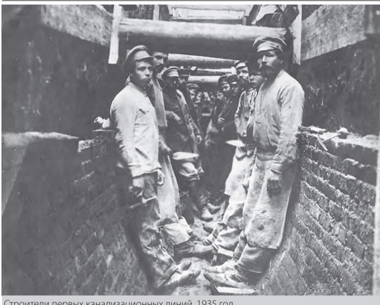
Строители первых канализационных линий. 1935 год.
