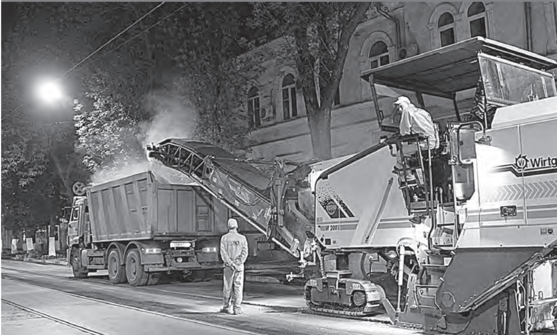
для отсыпки, например, грунтовых дорог. За одну ночную смену снимают покрытие на площади 4 000 квадратных метров. Общая площадь ремонтируемого участка - около 19 тысяч «квадратов», протяженность - 2 километра.
