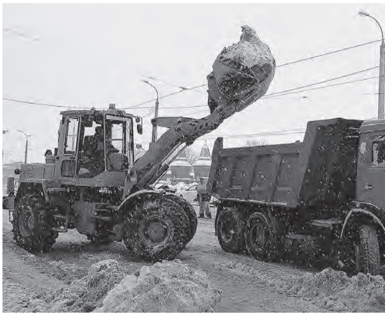
Работы контролируются круглосуточно. Это касается как расчистки улиц, так и вывоза снега. На специализированных площадках каждый самосвал взвешивают, сведения документируют. Все пункты приемки оснащены видеонаблюдением.
