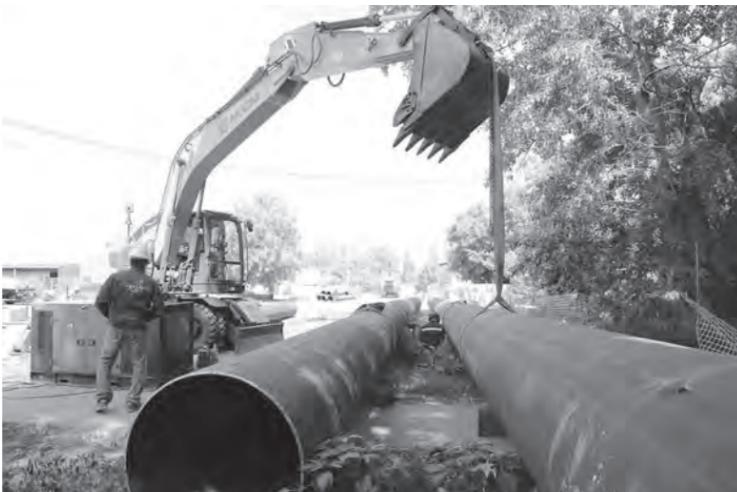
Маркса. В минувшие отопительные периоды на участке теплотрассы были зафиксированы технологические повреждения. По этой причине объект включили в план переключений на 2023 год. Протяженность реконструируемой трассы в двухтрубном исполнении составит 298 погонных метров.
