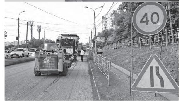
они ведутся по погоде. В частности, фрезерование не останавливается и при незначительных осадках. При этом укладка асфальтобетонной смеси выполняется только в сухую погоду.
